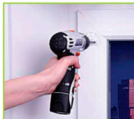
Закрепить кронштейны шурупами.
