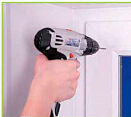
Просверлить отверстия d2 мм.
